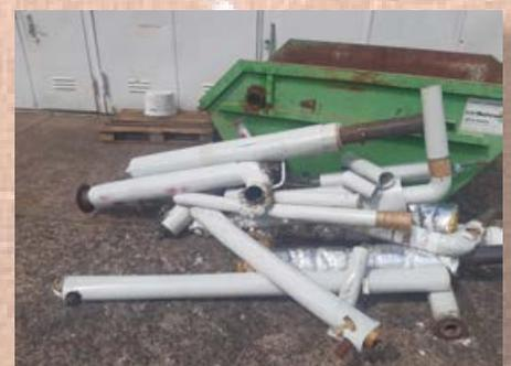
neralwolle, die als Isolierung in den vielen Rohrleitungen verbaut war, zurückgebaut und fachgerecht entsorgt werden musste. Nachdem alles zurückgebaut war, konnte mit der Installation der neuen Anlage begonnen werden. Unzählige Meter „Schwarzrohr“ wurden angepasst und verschweißt – alles in mühevoller Einzelanfertigung der benötigten Leitungsbauteile. Dies verschlang jede Menge Arbeitsstunden, die vorab nur sehr schwer kalkulierbar waren.
